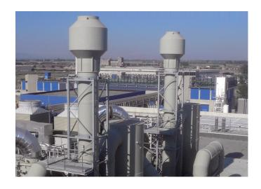
Construction en PPh, PEHD, PVC ou inox adaptée aux composés agressifs et corrosifs Débits traités jusqu'à 100 000 m<sup>3</sup>/h
